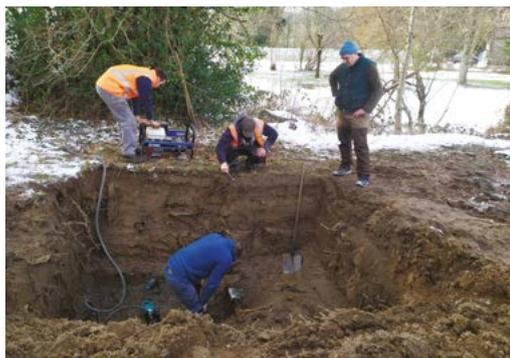
A Embourg, la conduite en fonte sur une partie ancienne du réseau s'était sectionnée. Les travaux réalisés en grande partie par les agents municipaux dans des conditions assez rigoureuses, ont consisté à dégager la conduite, à pomper l'eau, et enfin à poser un collier de réparation.
